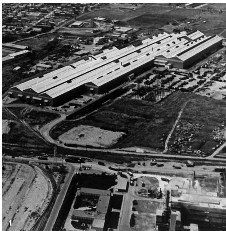
1. Γενική άποψη των εγκαταστάσεων του Χαλυβουργείου
